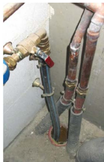
Calfeutrage des entrées de réseaux
