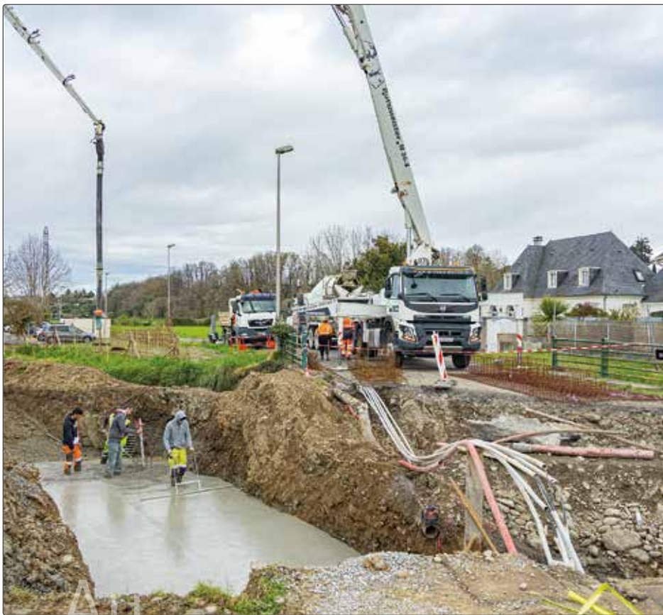
Les travaux du chemin de Lons.
